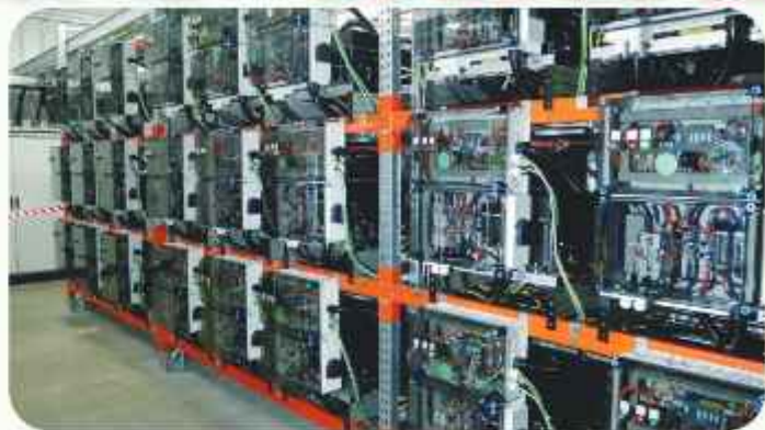
▲ 電動車退役電池二次利用儲能系統 (瑞曼迪斯利佩園區)
